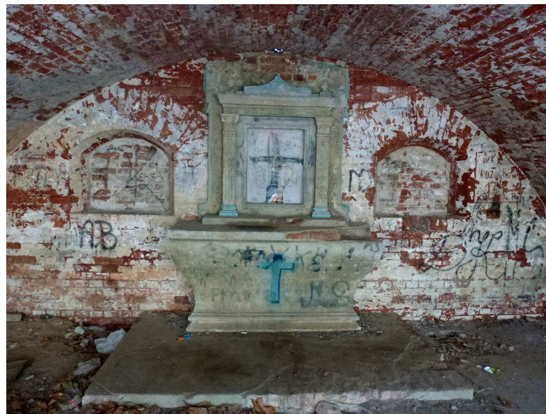
Widok na wnętrze przęsła południowego z ołtarzem.
