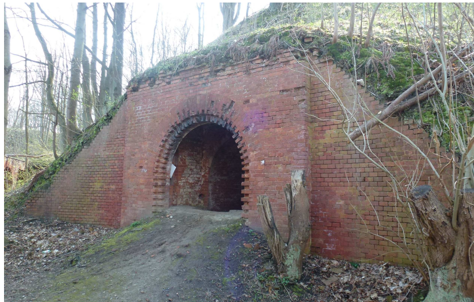
Widok od strony południowo-zachodniej
