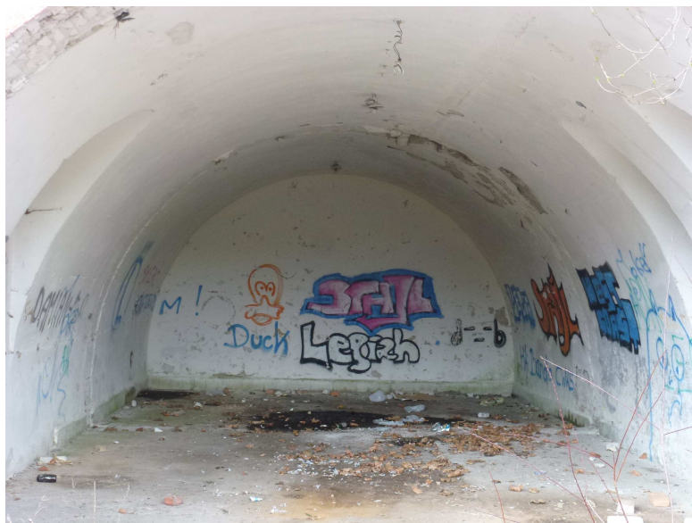
Wnętrze jednego z pomieszczeń
