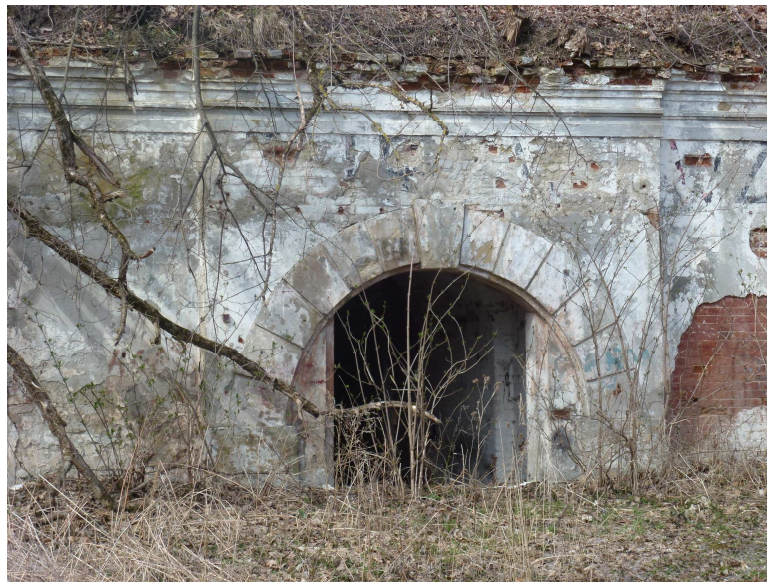
Widok na środkową część budowli.
