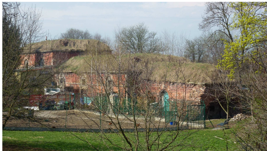
Widok od strony północno-wschodniej
