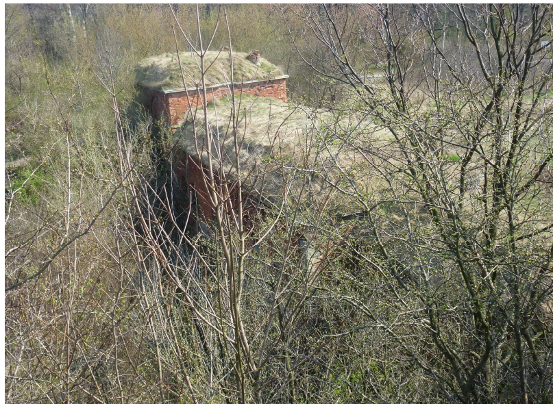
Widok od strony południowo-zachodniej
