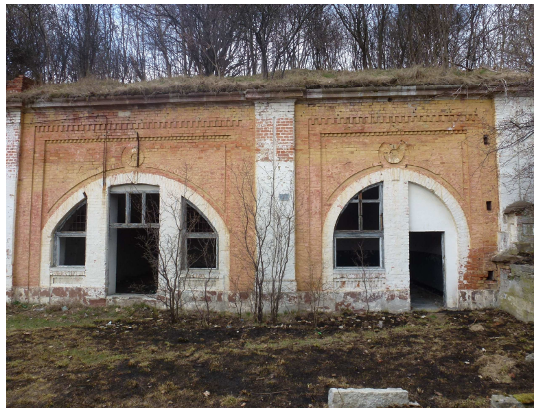
Widok na fragment elewacji od strony południowej.
