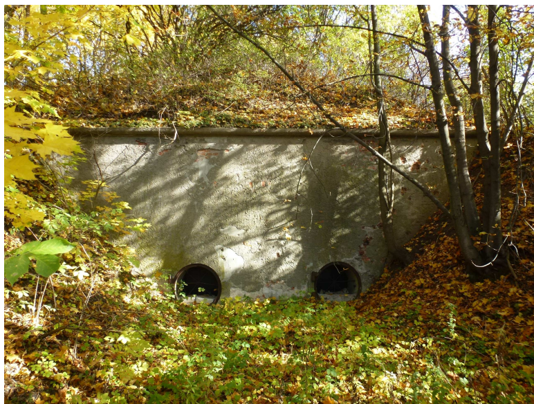
Ściana zachodnia (tylna) prochowni.
