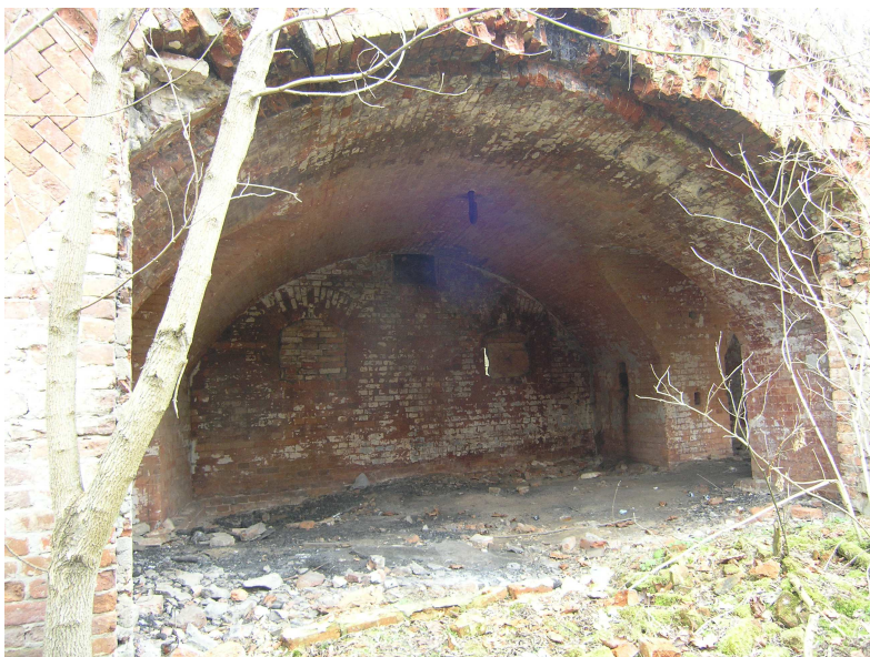
Widok na jedno z przęseł kaponiery.
