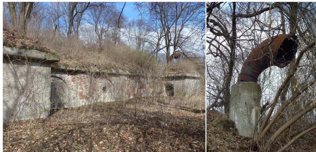
Widok od południowego-zachodu oraz komin wentylacyjny
