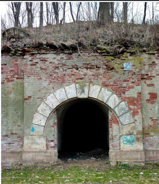
Ryzalit elewacji od strony południowej
