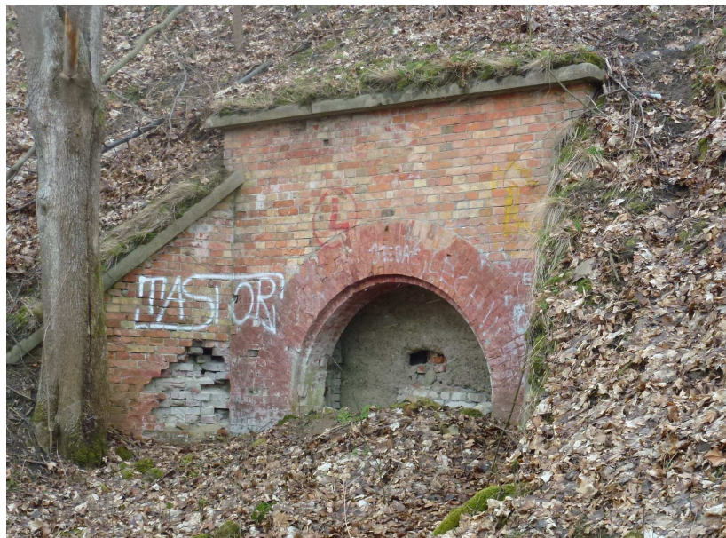
Widok od strony północnej.
