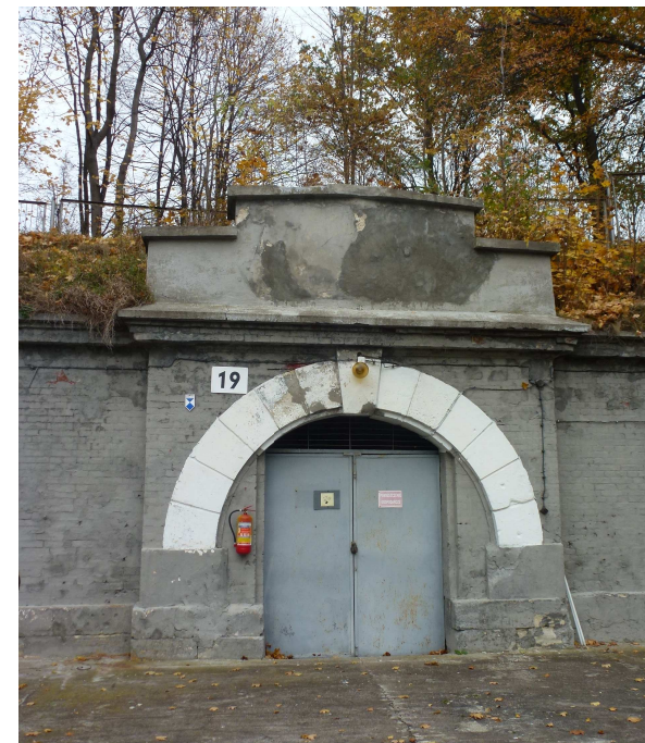
Widok na ryzalit poterny.
