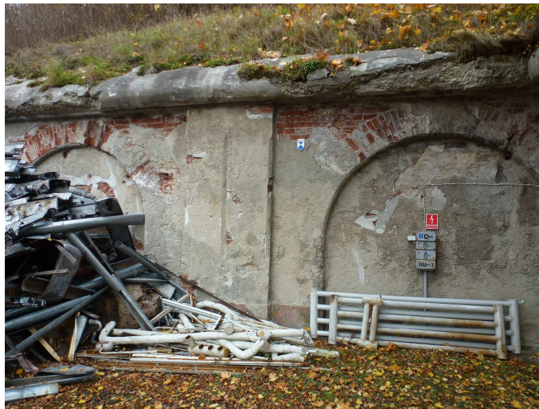
Widok na przęsła wewnętrzne prochowni.
