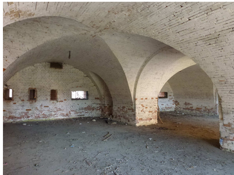
Widok na jedno z pomieszczeń kaponiery.
