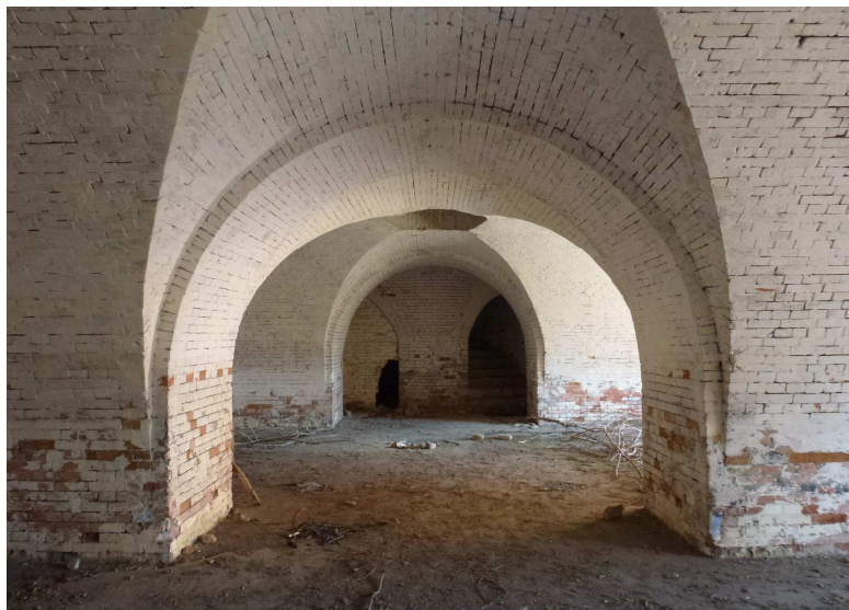
Widok na wnętrze w części kaponiery.
