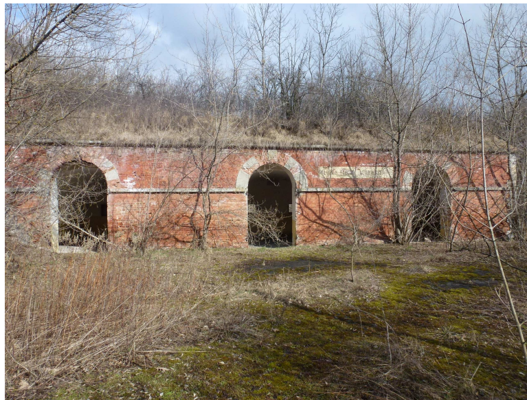
Widok na fragment budowli od strony południowej
