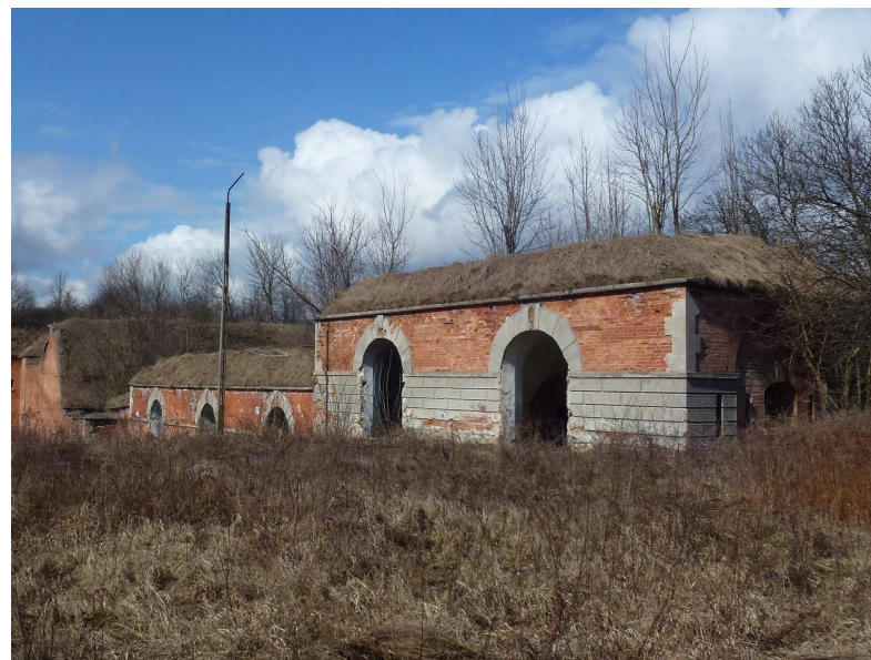
Widok na półkaponierę od południowego-wschodu.
