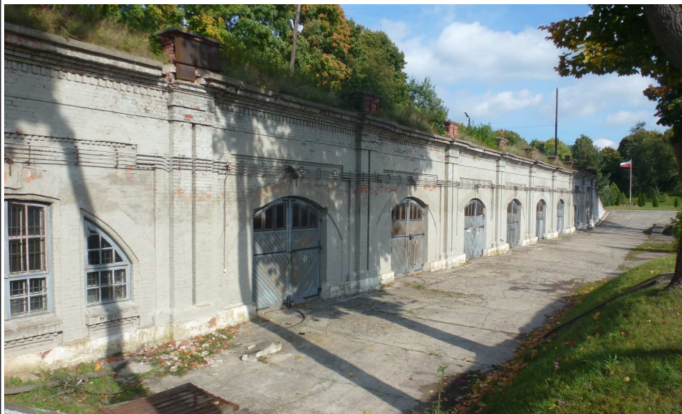
Widok od strony południowo-zachodniej
