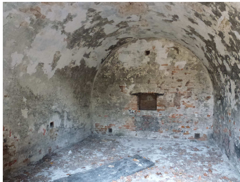
Wnętrze jednego z przęseł.
