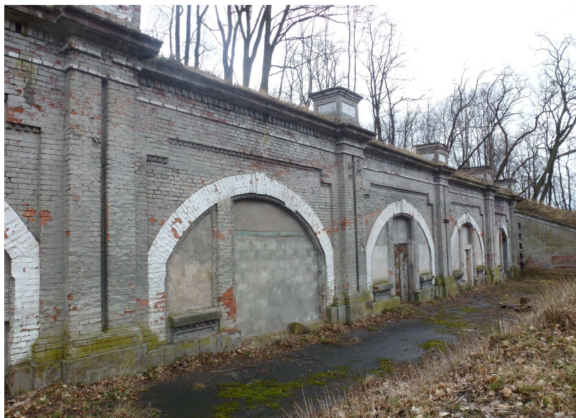
Widok na fragment elewacji od strony północno-zachodniej.
