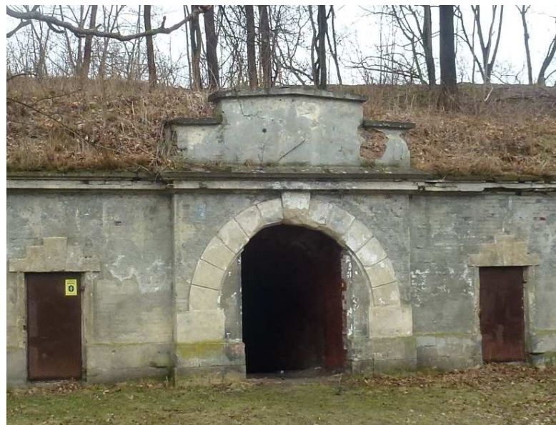
Widok na wejście do poterny.
