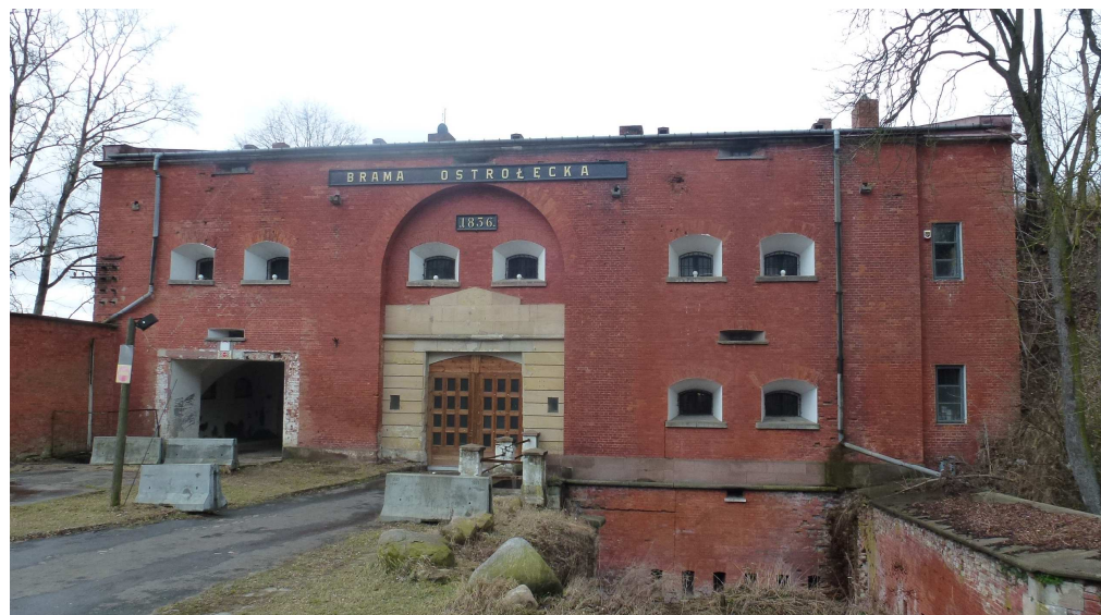
Widok na elewację wschodnią
