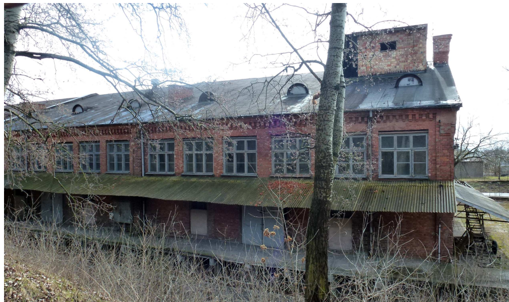
Widok od strony północnej.
