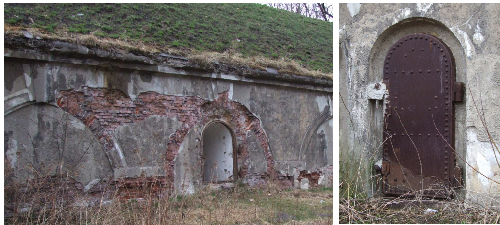
Widok na przęsła prochowni oraz pancerne drzwi wejściowe
