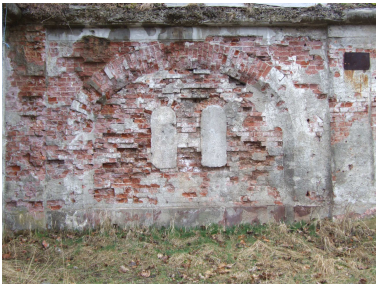
Widok na jedno z przęseł prochowni.
