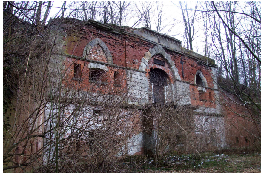
Widok na elewację północną.
