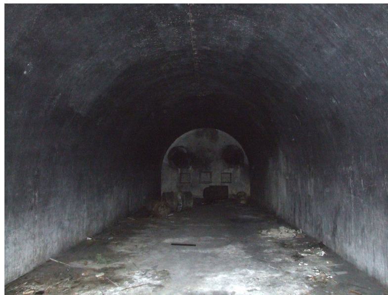
Wnętrze sali prochowni.
