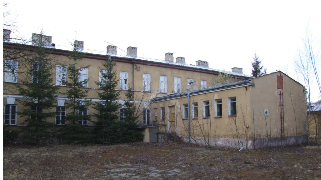
Widok na fragment elewacji tylnej budynku.
