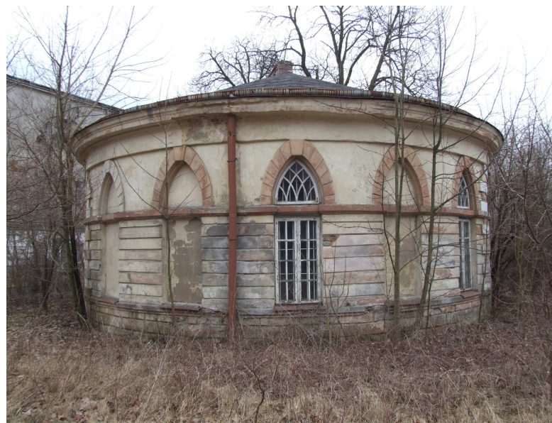
Widok od strony północno-wschodniej
