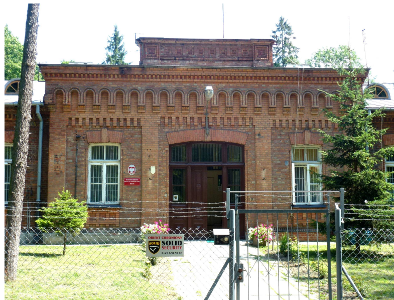
Widok na frontowy ryzalit budynku.
