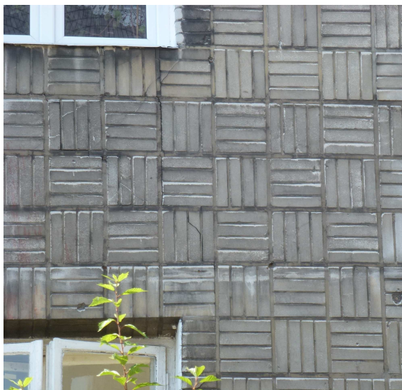
Detal ściany z okładziną ceglaną
