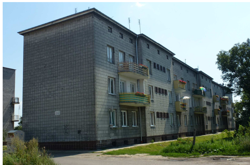
Widok od północno-zachodu
