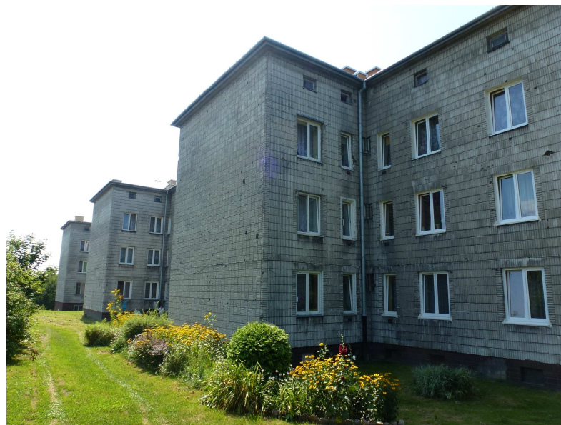
Widok od północno-wschodu
