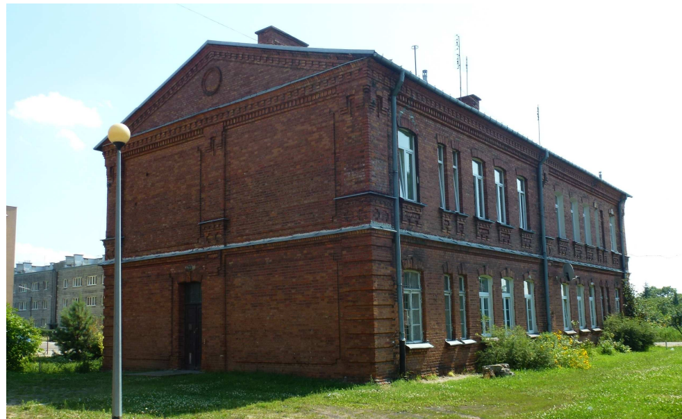
Widok od północno-zachodu
