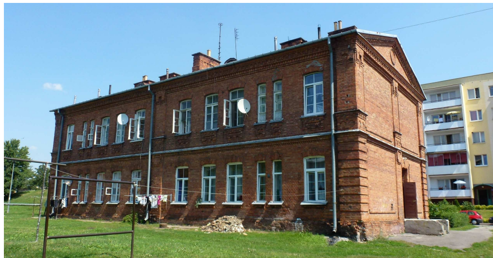
Widok od południowego-zachodu.
