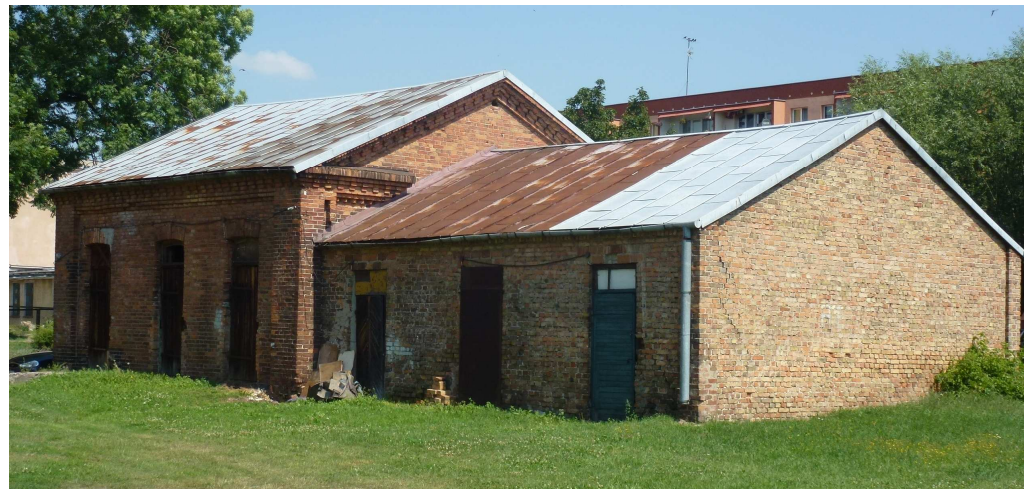
widok od południowego-zachodu.
