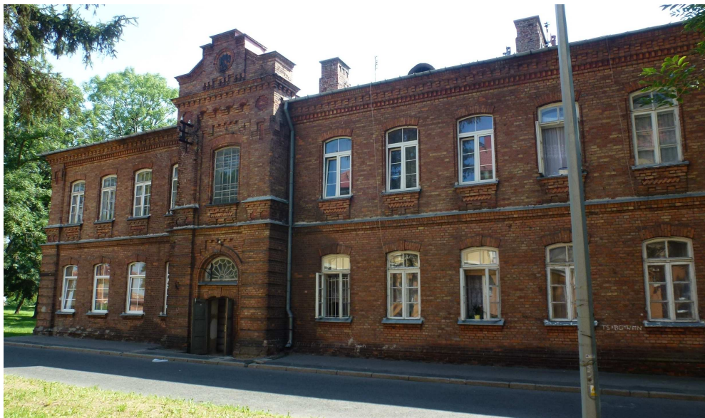
Widok na fragment elewacji frontowej od zachodu
