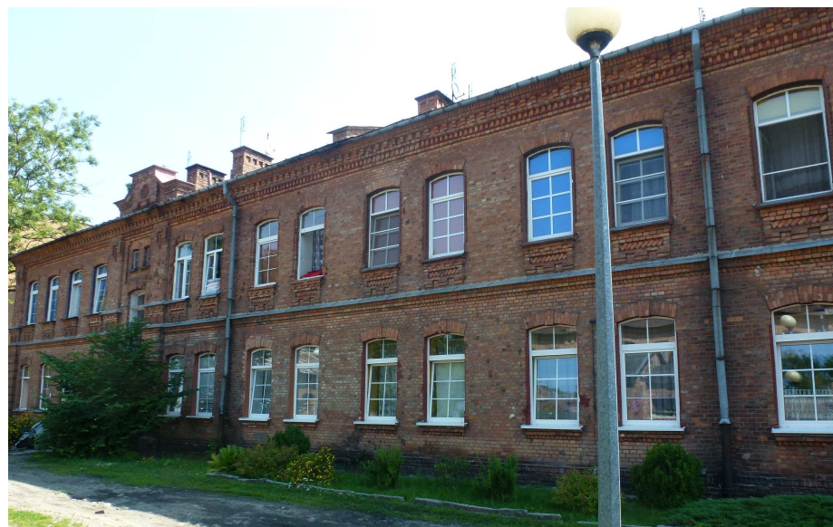
Widok na elewację tylną.
