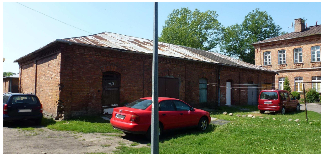
widok od strony północno-wschodniej.
