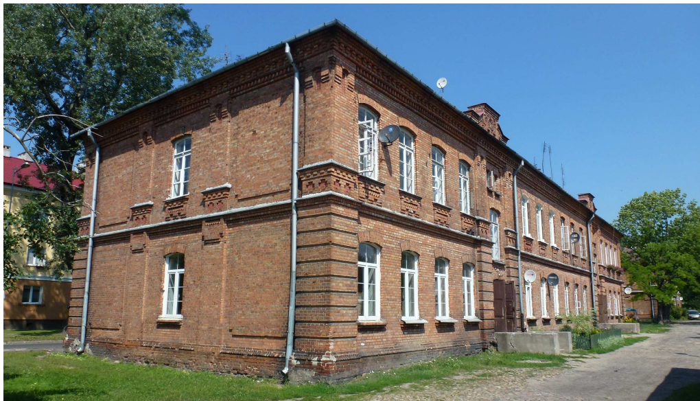
Widok od południowego-wschodu
