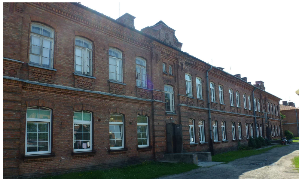
Widok na elewację tylną od północnego-zachodu
