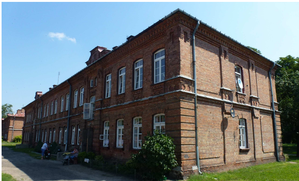
Widok na elewację tylną i szczytową od południowego-zachodu
