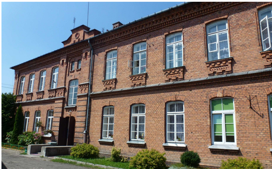
Widok na fragment tylnej elewacji
