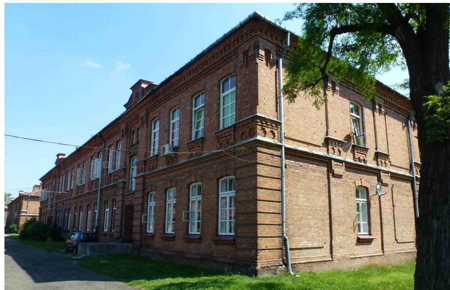
Widok na elewację tylną i szczytową od południowego-zachodu
