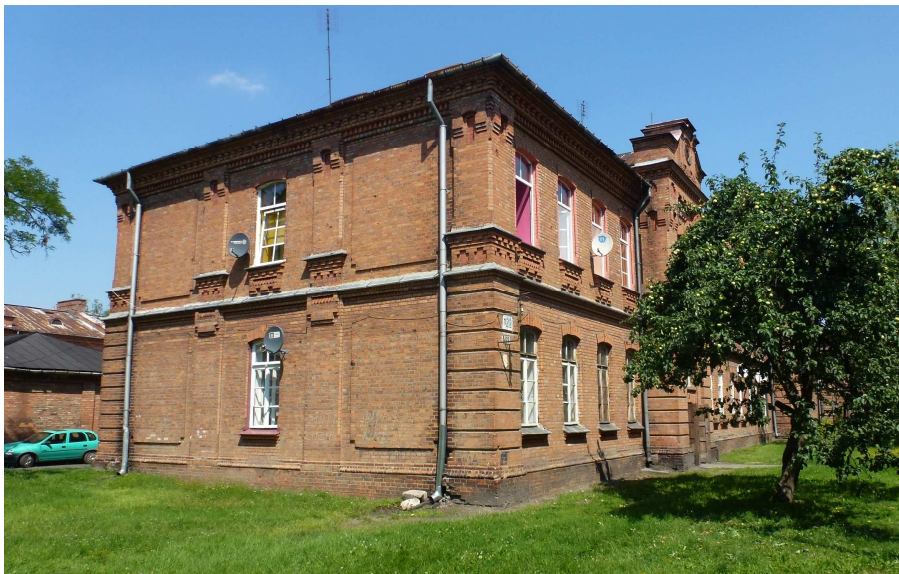
Widok na elewację szczytową od południowego-wschodu
