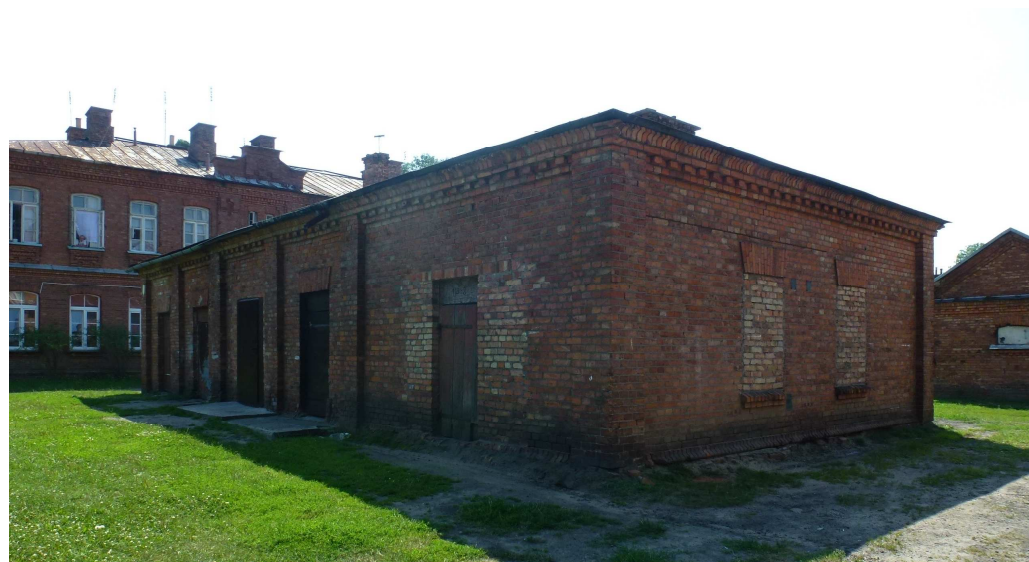
Widok od strony północno-zachodniej.
