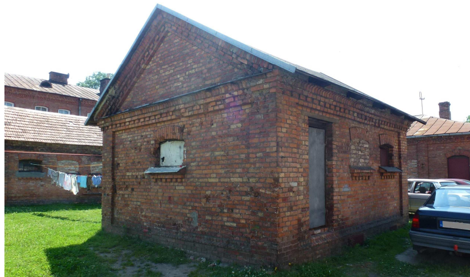
Widok od północnego-zachodu
