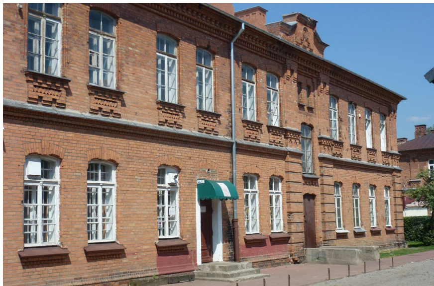
Widok na fragment elewacji tylnej od wschodu
