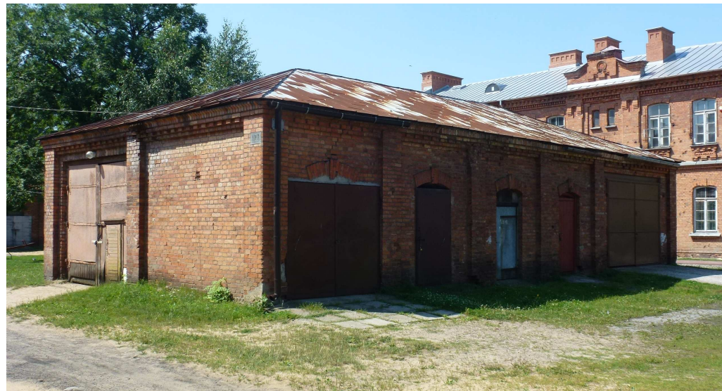
widok od strony północno-wschodniej.
