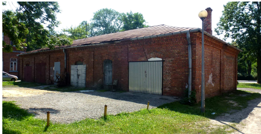
widok od strony północno-zachodniej.
