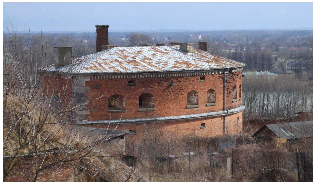
Widok od strony północnej.
