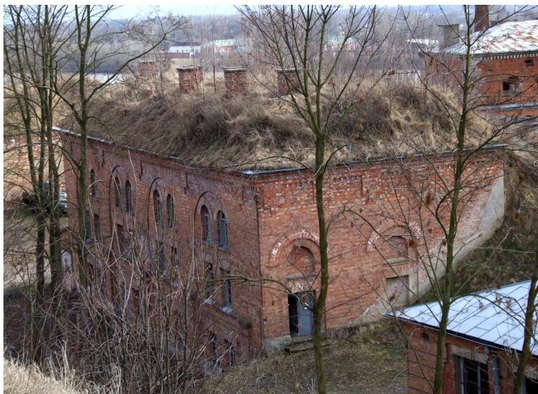
Widok od strony północnej
