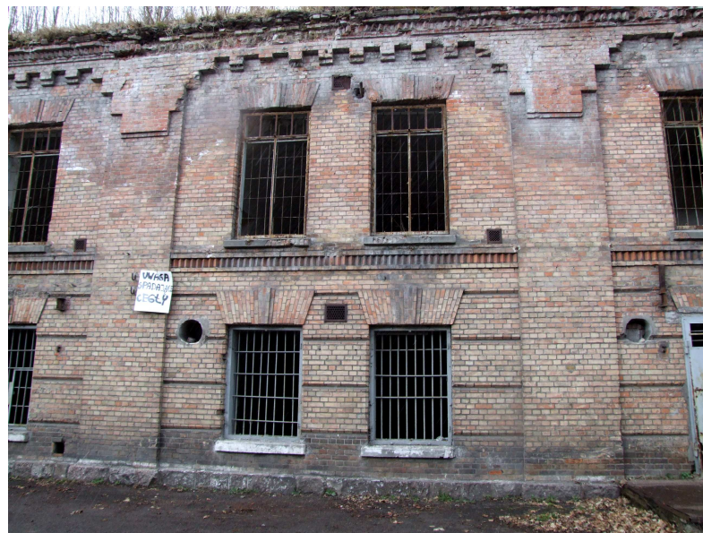
Widok na pojedyncze przęsło budynku
