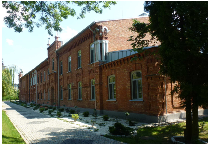
Widok od strony północno-zachodniej.
