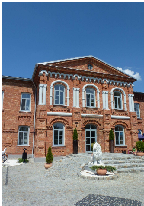
Widok od południa na ryzalit obiektu.
