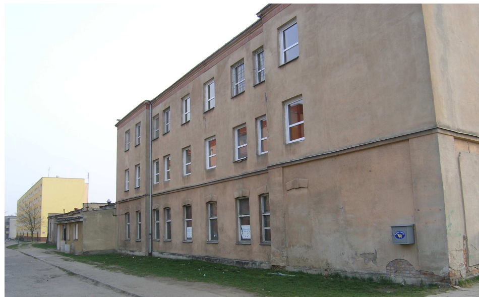
Widok na elewację wschodnią
